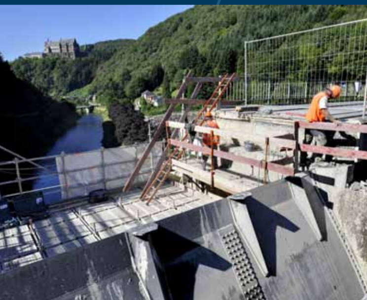
Die Umbauarbeiten an der Staumauer Lohmühle werden im Herbst abgeschlossen.
