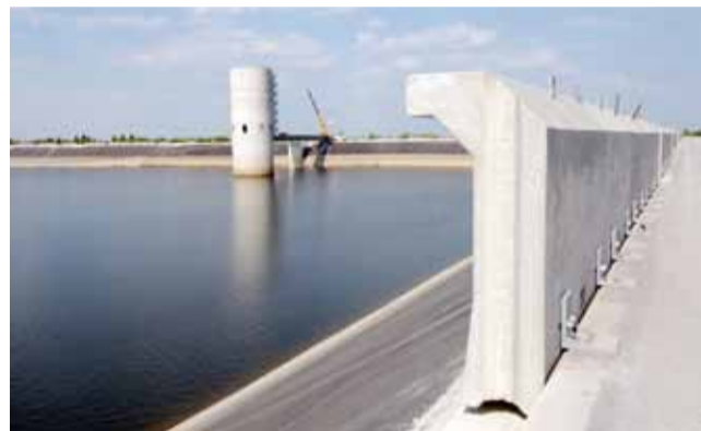
Die Arbeiten am Oberbecken zur Errichtung einer neuen Wellenschutzwand sind abgeschlossen.
