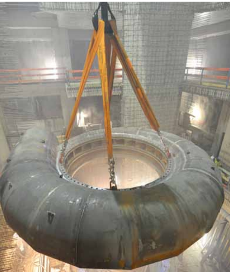
Einheben der Spirale
