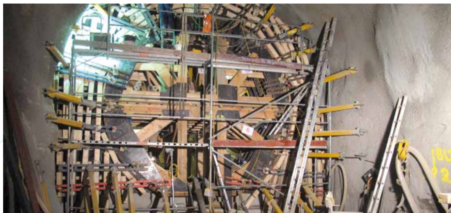
Momentan wird der 380 m lange Unterwasserstollen einbetoniert.
