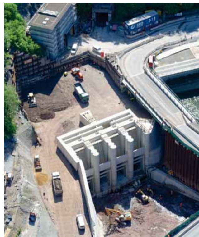
L'ouvrage de sortie en août
