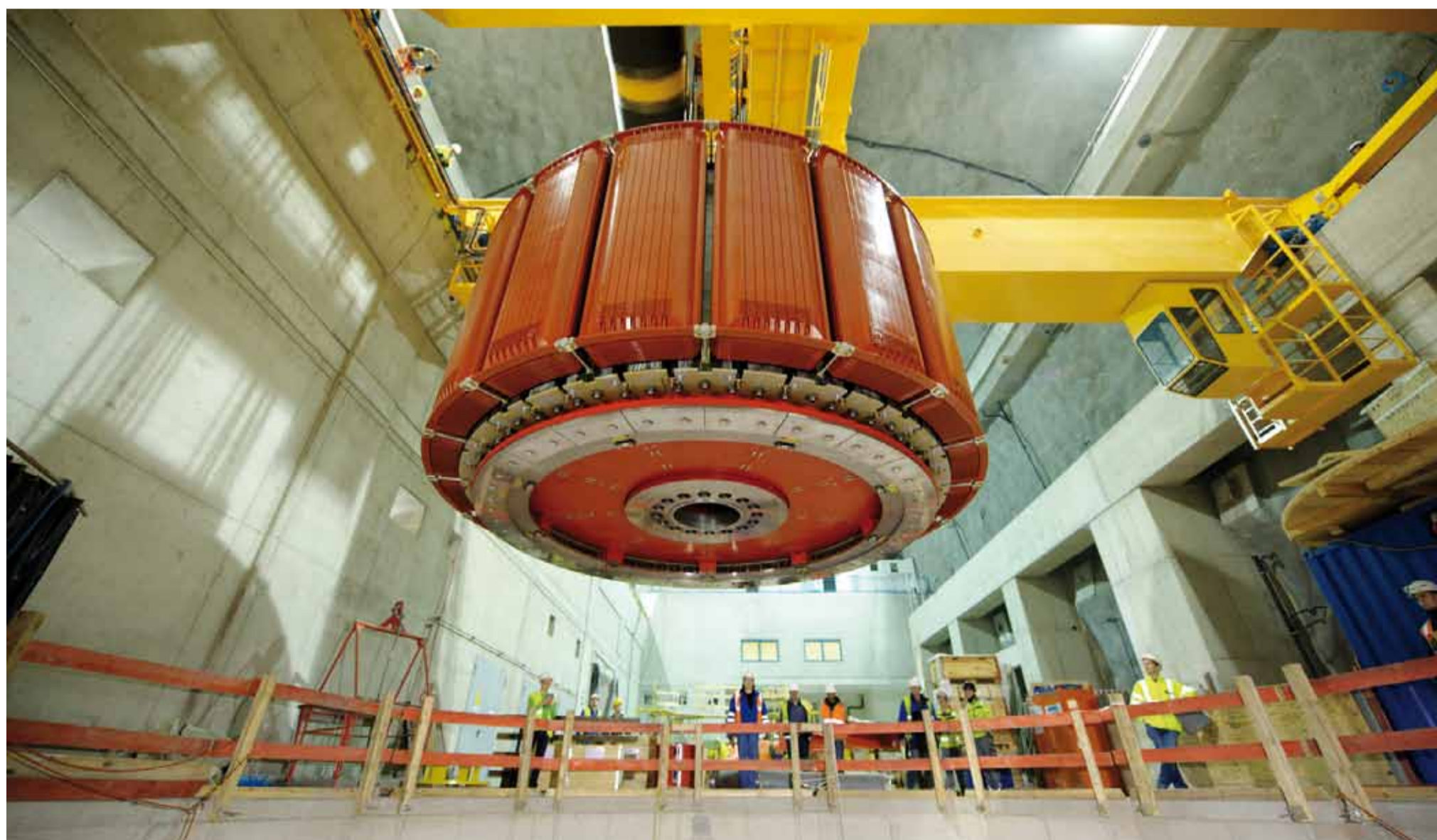
Le générateur a été installé le 13 juin de cette année
