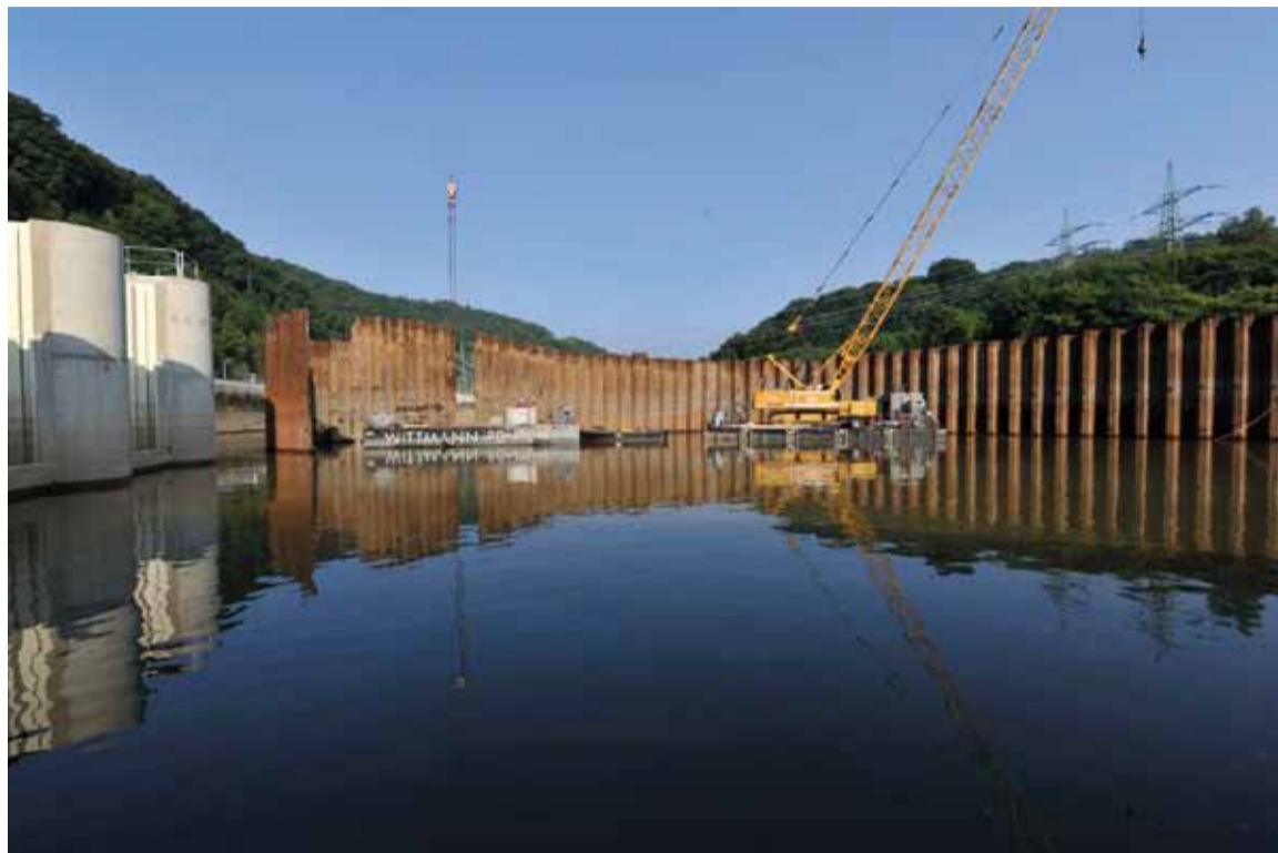
Démontage du batardeau à double encoffrement en août
