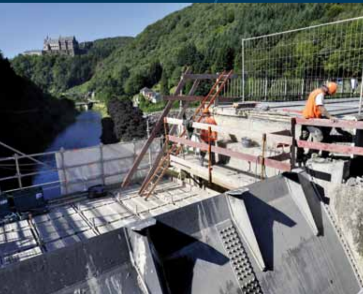
Les travaux de transformation au mur de barrage Lohmühle seront réalisés en automne.
