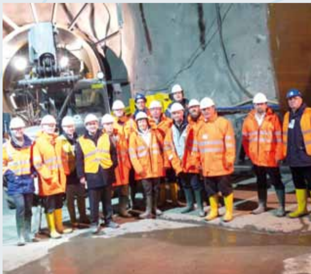
Les responsables des communes de Vianden, Tandel, Pütscheid et Kerpshausen se sont informés sur place sur l'avancement des travaux.
