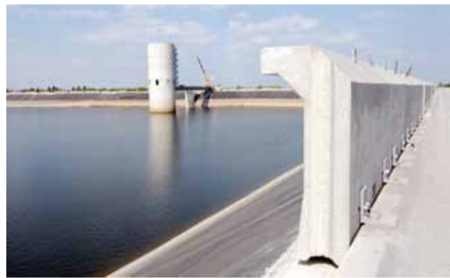
Les travaux pour la réalisation d'une paroi pare-vagues au bassin supérieur sont terminés.
